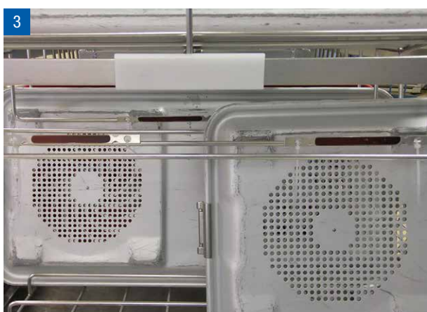
Edelstahlplättchen mit Kabelbinder befestigt
